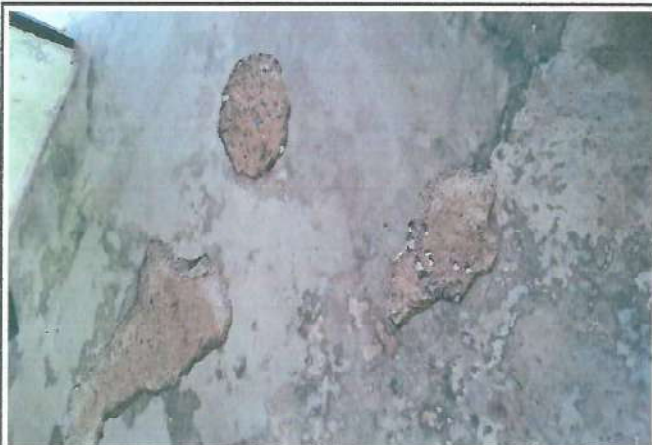
Foto 3: cambio de piso del corredor de la escuela
