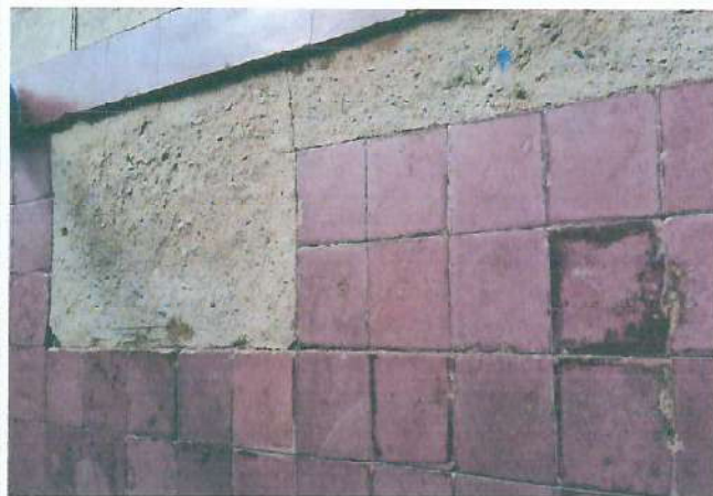
Foto 2: cambio de piso del corredor principal
